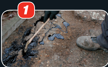
Primer aanbrengen
