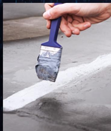
**FILLCOAT® FIBRES****Avec fibres pour rebouchage des fissures**
