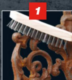
Lösen Rost und beschädigten Anstrich mit Spachtel und Stahlbürste entfernen. Glatte Deckanstriche anrauen um eine gute Haftung zu erzielen.
