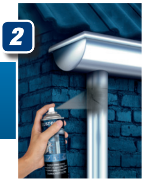
Product aanbrengen in meerdere lagen (na 30 minuten)
